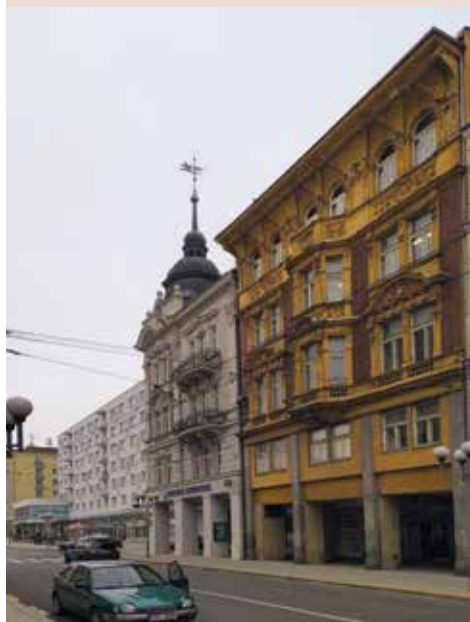
Dům na Horním náměstí 47 s oranžovou fasádou dříve vlastnila rodina Pavla Ecksteina.
