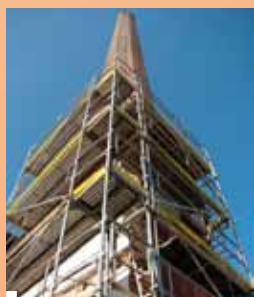
ÚNOR 2011 statické zajištění komínu
