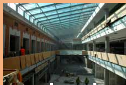
ČERVENEC 2012 uložení posledního kubíku betonu
