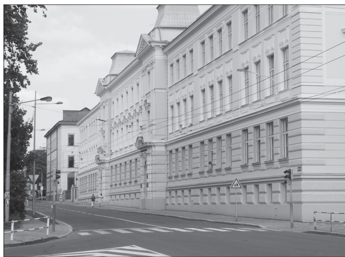
Budova Mendelova gymnázia dostala nedávno nový kabát a stala se ozdobou svého okolí. Foto: Václav Pustějovský
