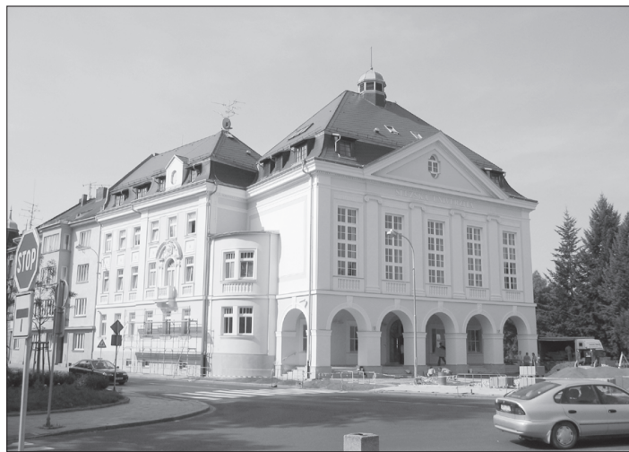
Rekonstruovaná budova někdejšího administrativního sídla vojenské posádky, později po dlouhá desetiletí známá jako Vojenský klub, dostává po rekonstrukci zcela nové využití.
