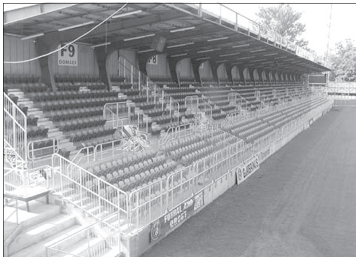
Po ukončení rekonstrukce se počet míst k sezení výrazně zvýší.
