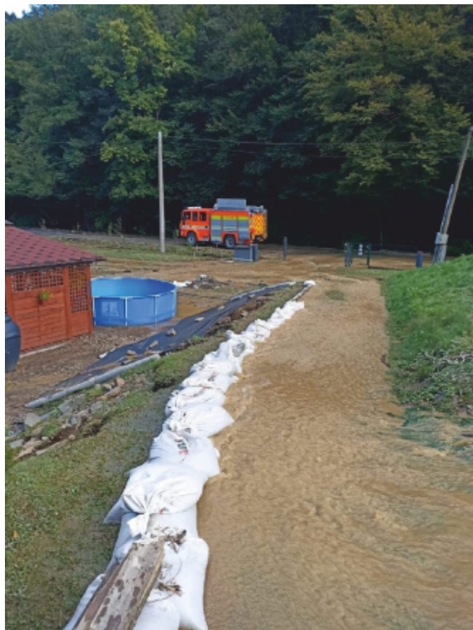
Námi postavená hráz, která odvádí přetékající vodu z Valchy
