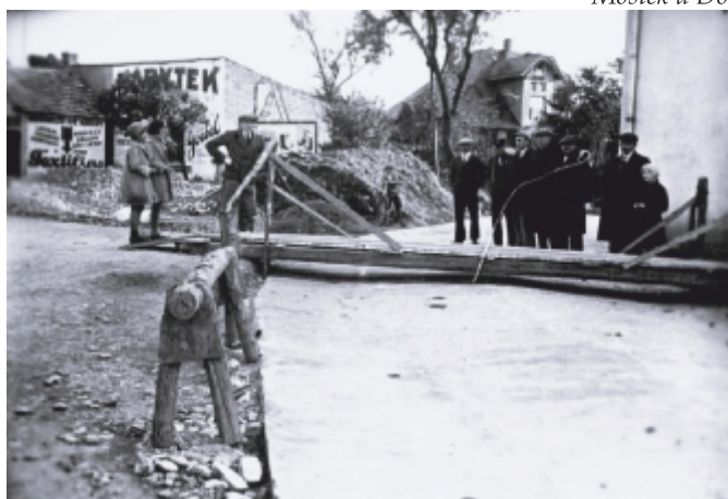
Oprava Kremličky v Háji
