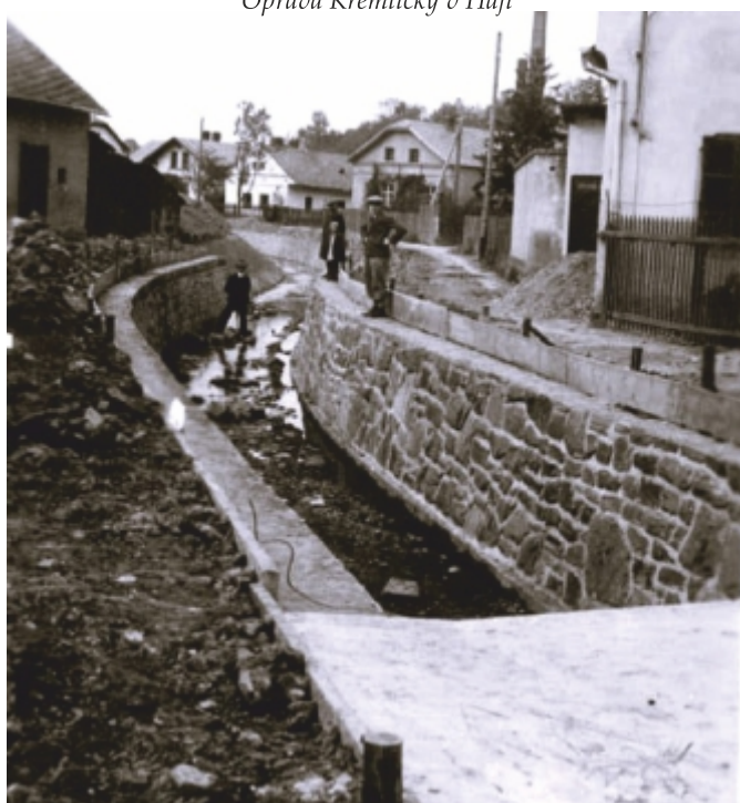
Oprava Kremličky v Háji
