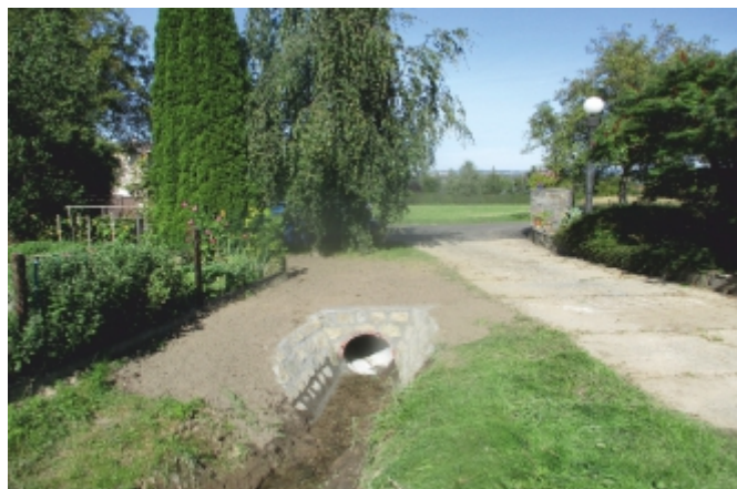
Částečné zatrubnění a zpevnění oplocení u potoka pod Šilerem PO
