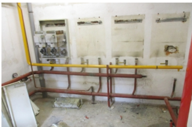
Rekonstrukce kotelny v MŠ Háj PŘED
