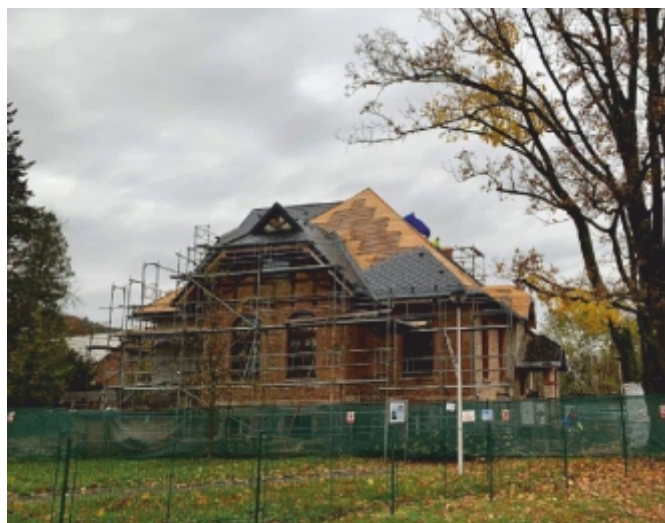
Rekonstrukce a přestavba Dohnálkova vila PRŮBĚH
