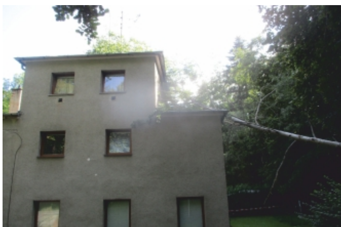
Odstranění spadlého stromu ul. Hrabyňská
