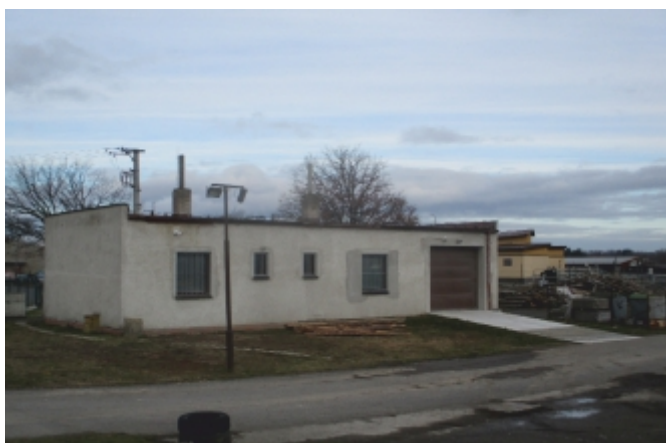
Nové okna, mříže a vrata - sběrný dvůr
