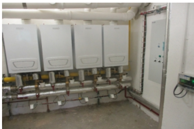
Rekonstrukce kotelny v MŠ Háj PO
