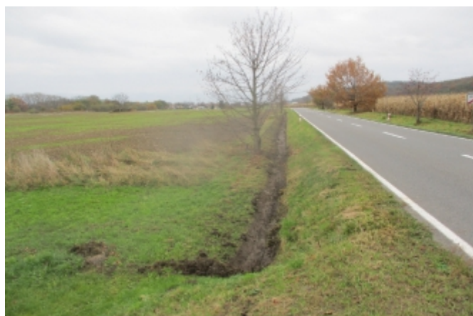
Vyčištění příkopu mezi Smolkovem a Lhotou
