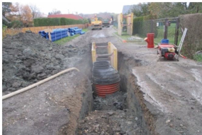
Začátek výstavby kanalizace v Jilešovicích
