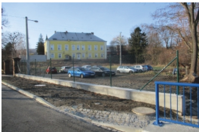
Oprava oplocení pod Domovem Ludmila ve Smolkově
