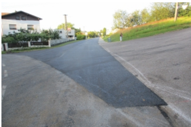
Nový asfaltový povrch na ul. Pod Ostrou hůrkou
