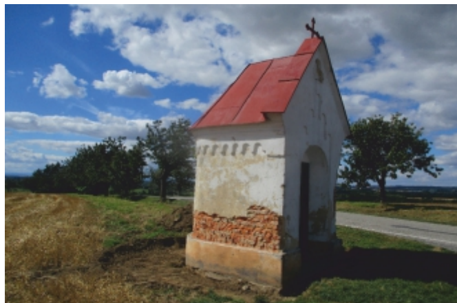
Rekonstrukce kapličky v Jilešovicích PRŮBĚH
