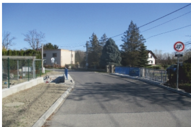
Dodělané zábradlí na ul. Poddubí ve Smolkově
