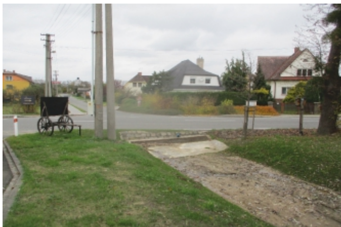
Rekonstrukce kanalizační vpustě u hasičárny ve Lhotě
