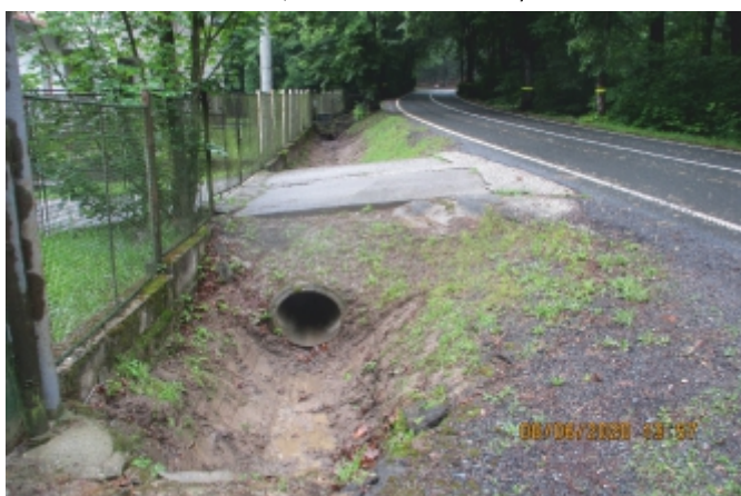
Vyčištění příkopu na ul. Hrabyňská
