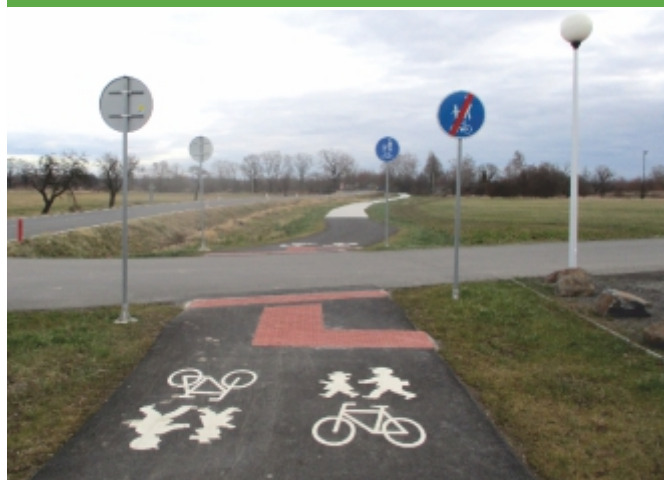
Vybudování stezky pro chodce a cyklisty od železničního přejezdu po most přes řeku Opavici
