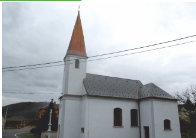
Kompletní rekonstrukce kaple na návsi v Jilešovicích
