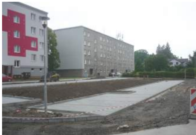
Rekonstrukce ul. Družstevní - parkoviště Háj
