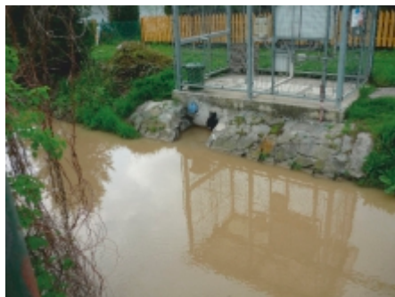
úprava přepadového otvoru v přečerpávací stanici ve Smolkově
