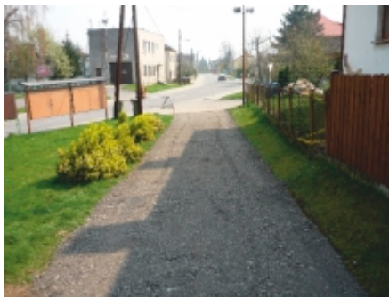
oprava cesty Na Štřídkovci ve Smolkově
