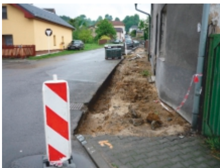
oprava chodníku ul. Velká strana v Chabíčově
