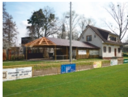
výměna rozbité krytiny na fotbalovém hřišti v Háji
