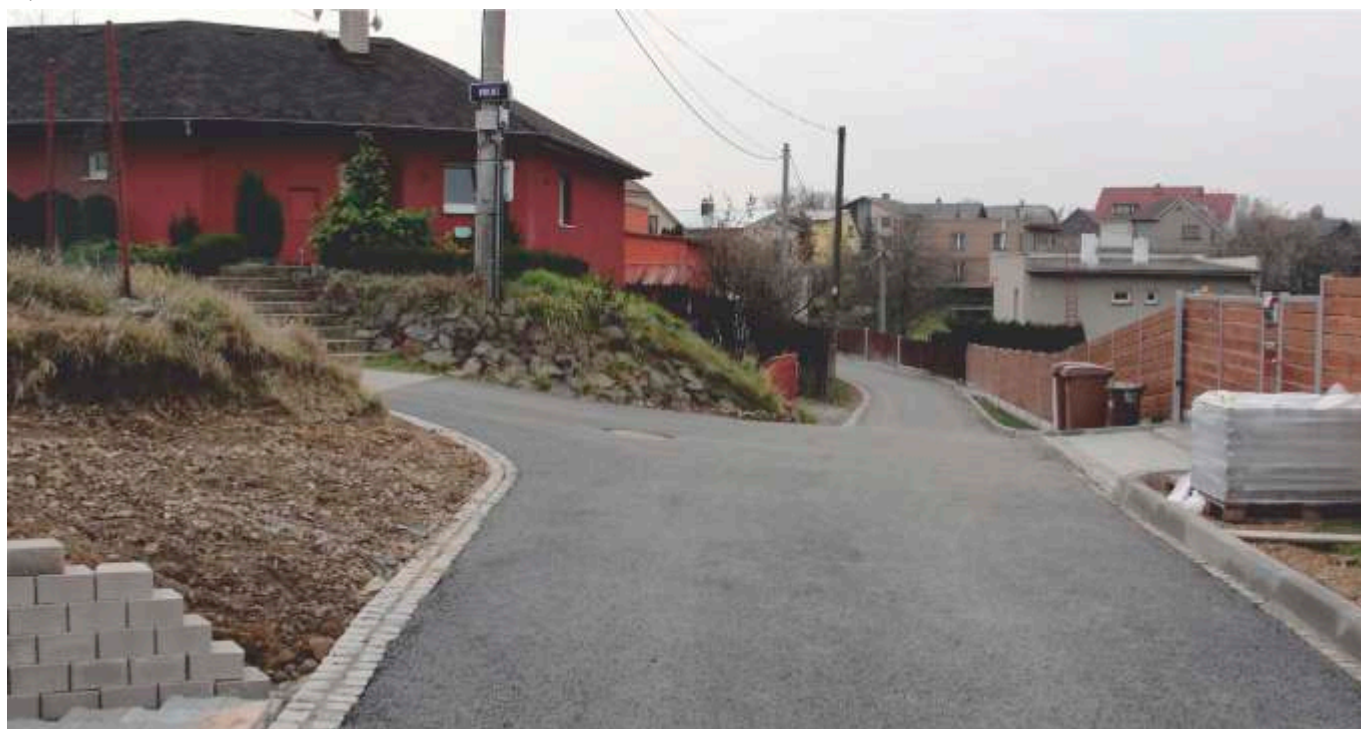
Nová vozovka na ulici Záhumení
