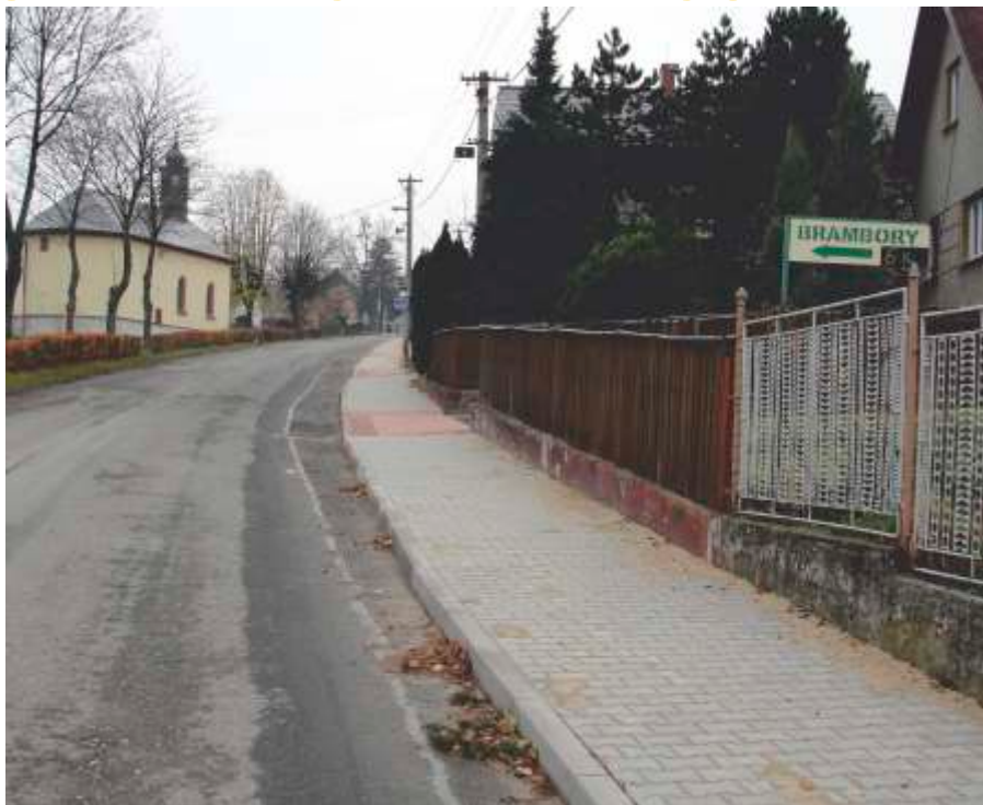
Zrekonstruovaný chodník podél Ostravské ulice
