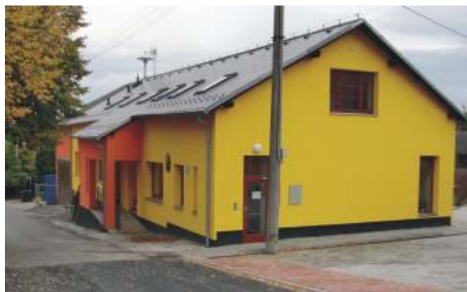
Rekonstruovaná Mateřská škola v Budišovicích
