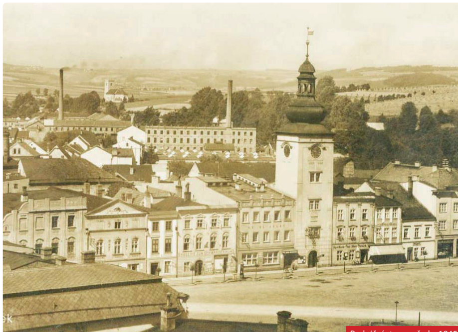
Radniční strana před r. 1945
