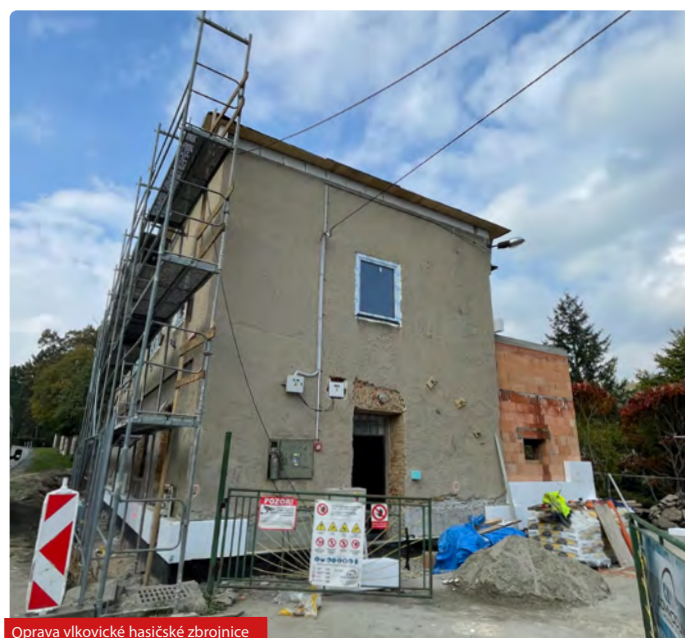
Oprava vlkovické hasičské zbrojnice
