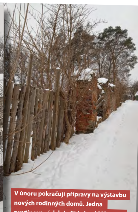
V Jerlochovicích vede ke kostelu, jehož interiér ještě v lednu zdobil nový betlém, zrekonstruovaná cesta. Zároveň v Jerlochovicích pokračuje příprava suchého poldru, který zde tak chybí
