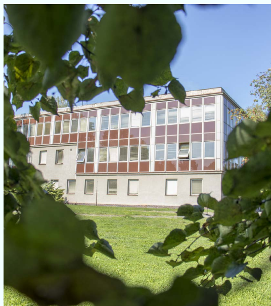
Potřeba moderního objektu MŠ
