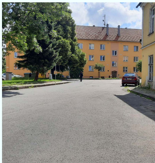
Nezbytné rekonstrukce komunikací a chodníků
