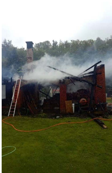
Požár stodoly v Dolejších Kunčicích
