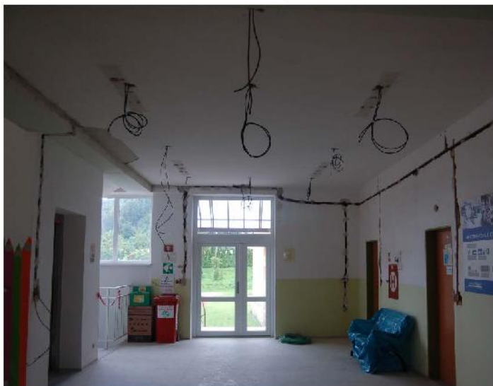
Před a po rekonstrukci elektroinstalace
