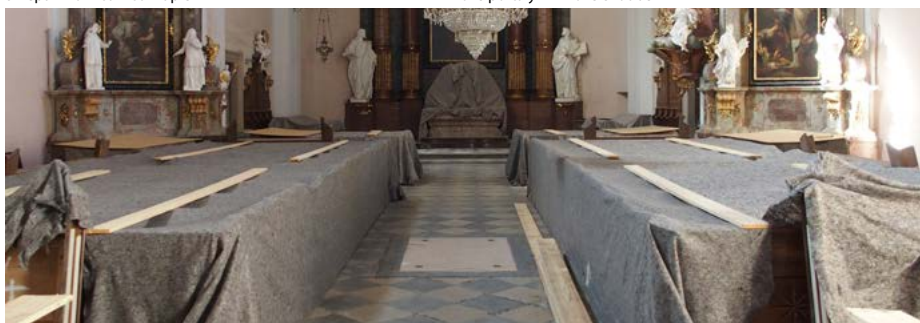
Zabezpečení lavic, rakví a hlavního oltáře
