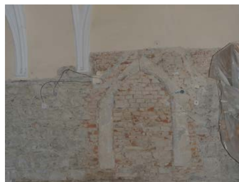
Nové portály v křížové chodbě
