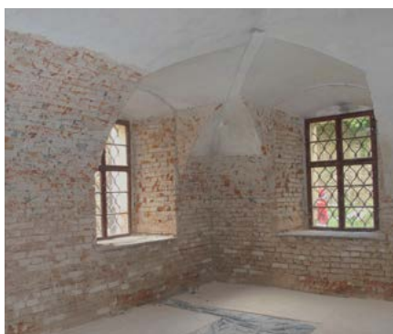
Oklepání zdi v sakristii kaple
