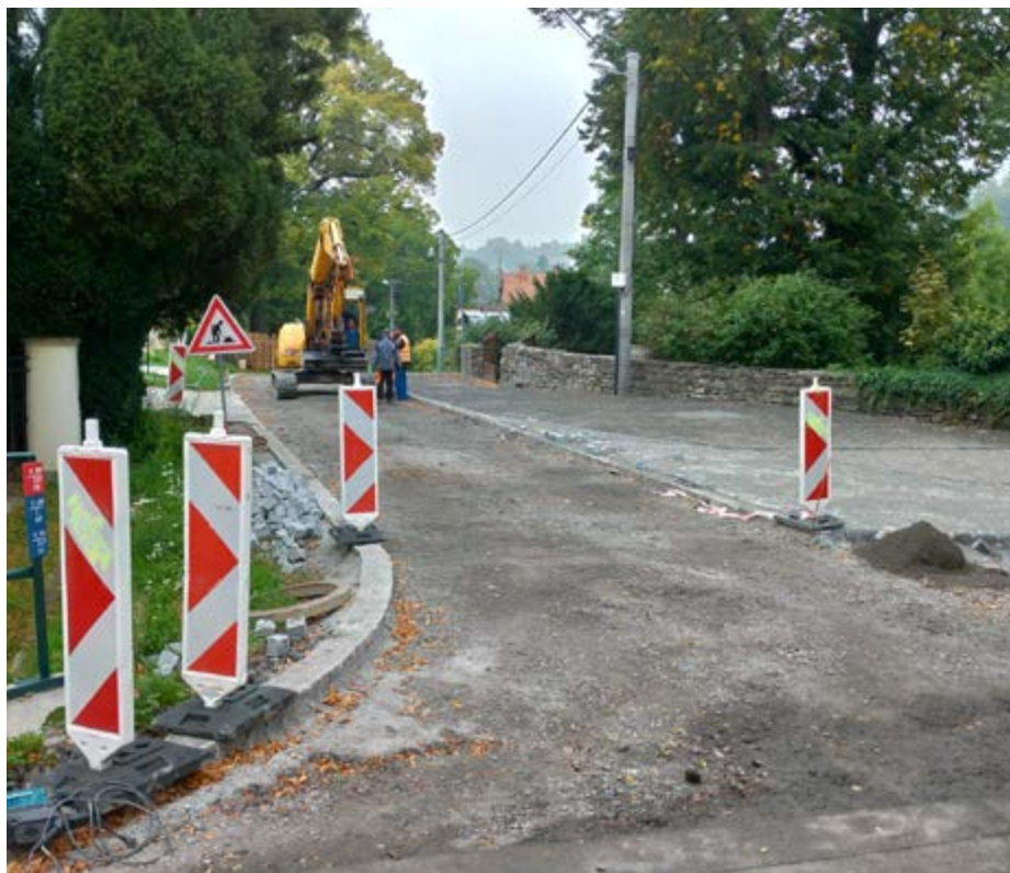
Rekonstrukce Kapucínské ulice.
