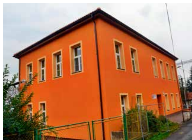
...a těsně před ukončením stavby.
