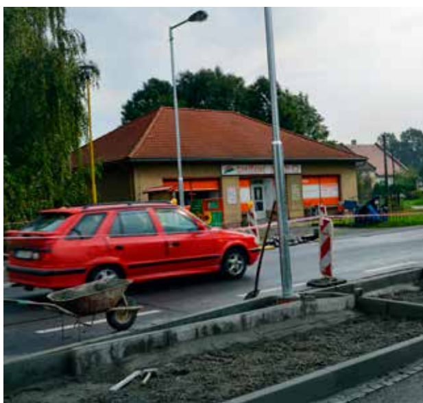
Ve Stachovicích finišuje stavba přechodu s bezpečnostními prvky.
