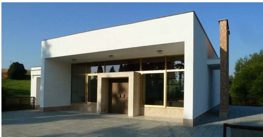
Pohled na smuteční síň po rekonstrukci v červenci r.2013
