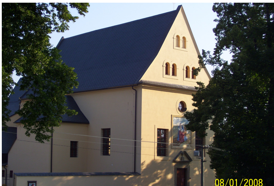
Kostel sv. Josefa po rekonstrukci
