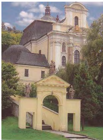
Současný pohled na schodiště
