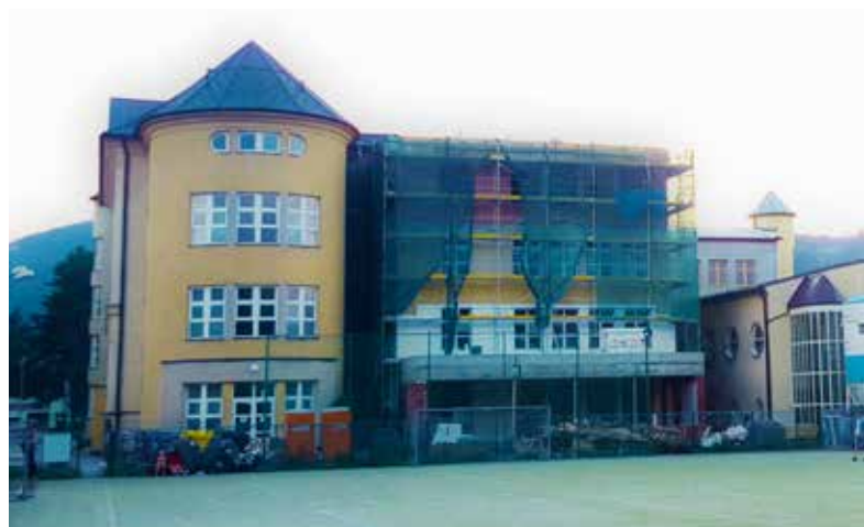
ZŠ Komenského nástavba odborných učeben s vybavením, bezbariérovým přístupem a přístavba školní jídelny. Náklady na realizaci 14 mil. Kč. (spolufinancováno z dotací ITI/IROP).
