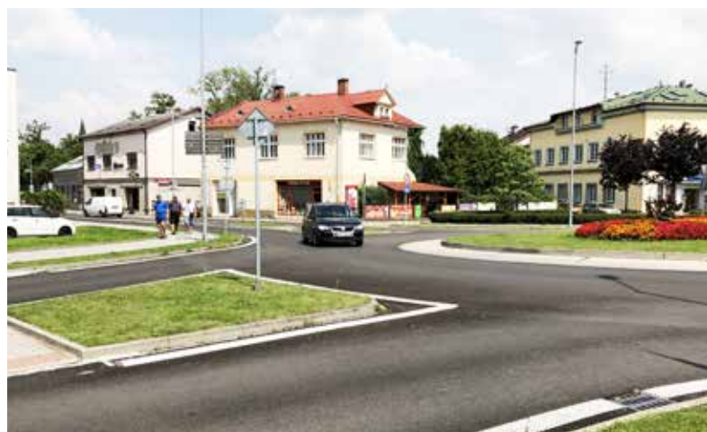
Rekonstrukce povrchu komunikace průtahu městem od Nové Dědiny po Pržno. Investorem je Moravskoslezský kraj. K úpravě kanálů, sjezdů apod. dojde po vyasfaltování problémových úseků v Pržně a Bašce.
