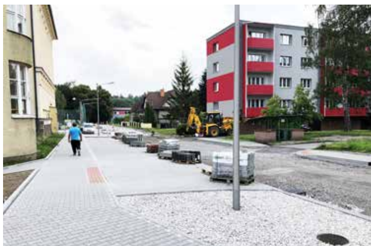
Generální oprava komunikace na ul. Komenského včetně přeložek kanalizace, veřejného osvětlení a dalších sítí. Cena díla 7,5 mil. Kč (z vlastních zdrojů)
