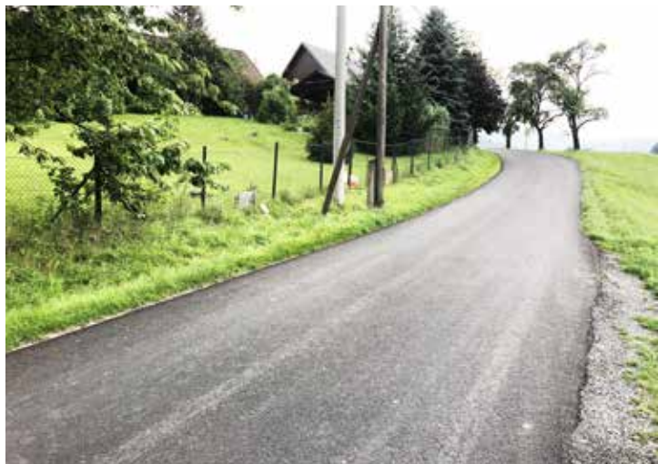
Oprava povrchu části komunikace Lubno (Tutto směr Malenovice), po vypořádání majetkových poměrů dojde k realizaci další zbylé části.
