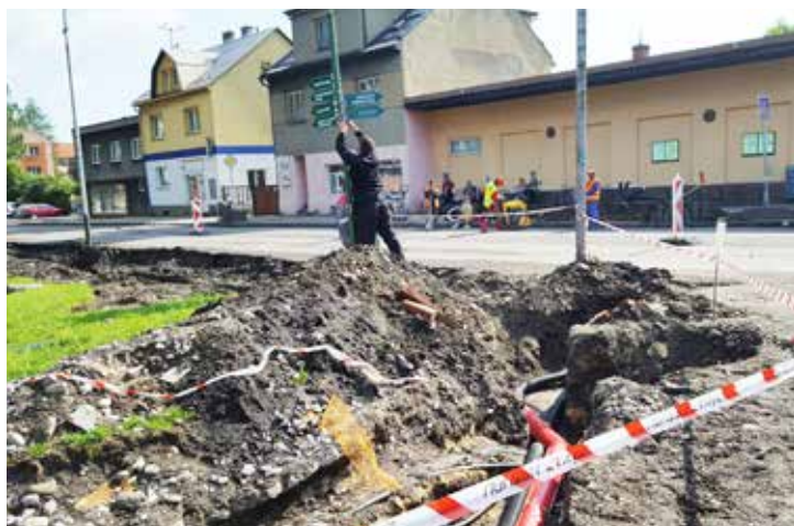
Rekonstrukce křižovatky u kolejí vč. části ul. Poštovní se zřízením autobusových zálivů, II. etapa. Investorem je Moravskoslezský kraj společně s městem. Cena díla za obě etapy 15 mil Kč.
