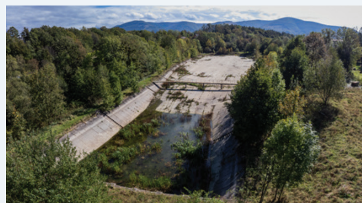
Současný stav před obnovou
