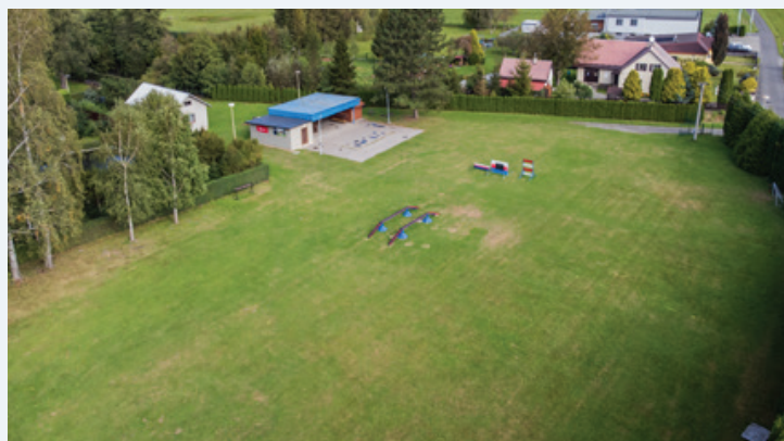
Současný stav před obnovou
