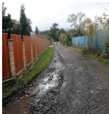
Tobolář před opravou
