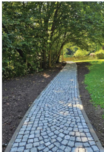
Povrch nového chodníku tvoří žulové kostky a betonová zámková dlažba
