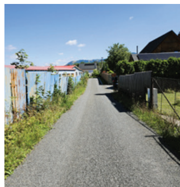
Tobolář po opravě
