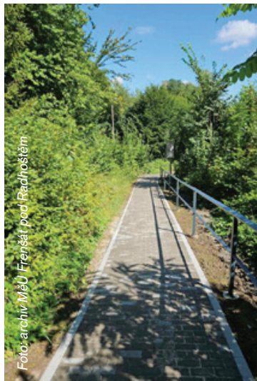
Povrch nového chodníku tvoří žulové kostky a betonová zámková dlažba
