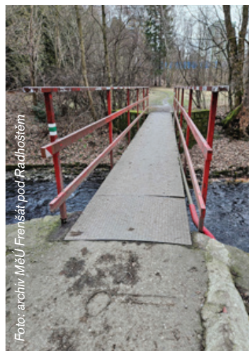
Lávka u Hotelu Bartoš před a po opravě
