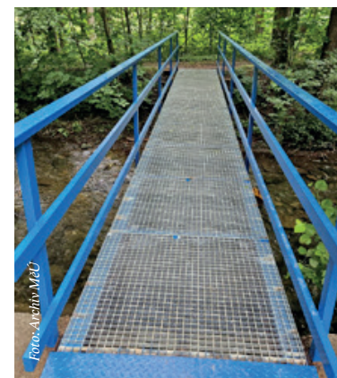
Lávka po opravě
