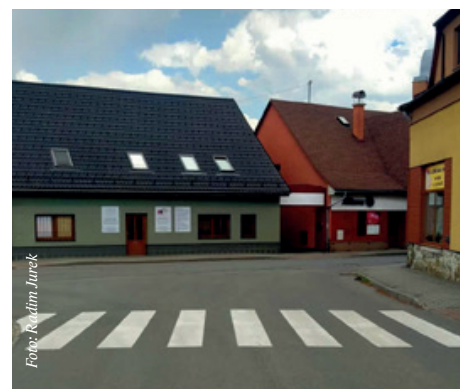
Silnice ve Frenštátě prokukly. Město nechalo obnovit vodorovné značení
