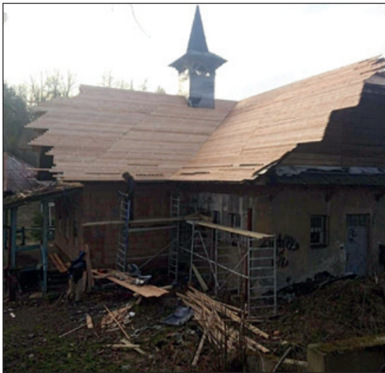
Oprava střechy a okolí Staré Vlčiny
