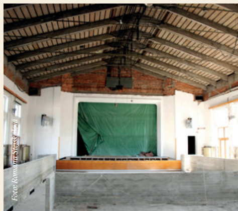
Rekonstrukce velkého sálu
