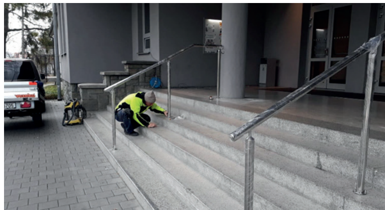
Žulové schodiště před Domem kultury doplnilo nerezové zábradlí
