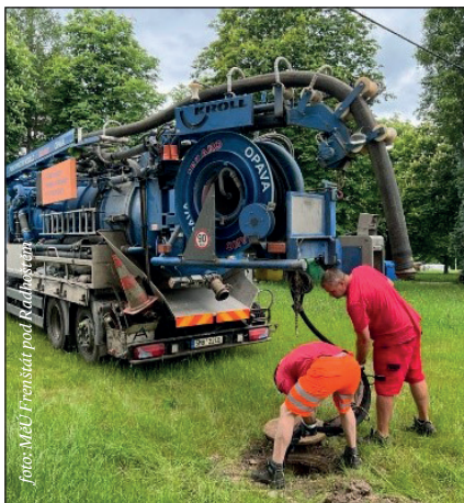
Čištění a monitoring kanalizace
