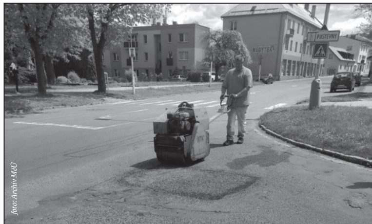
Oprava výtluků, ul. Fr. Palackého, Frenštát pod Radhoštěm, květen 2023
