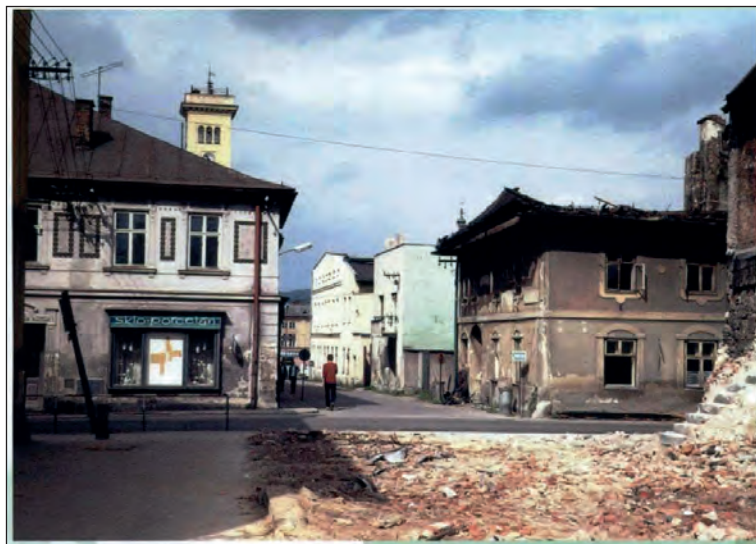
Demolice hospody Na Rožku, kde se narodil historik Libor Knězek
