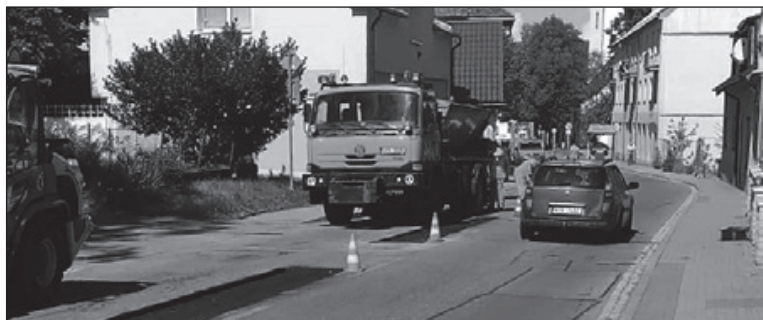
V srpnu začali silničáři opravovat a zasypávat výtluky v Horní ulici
