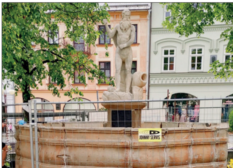
Výškový rozdíl, který vznikl po vybudování nové železobetonové desky, bude ještě upraven pomocí dalšího žulového stupně
