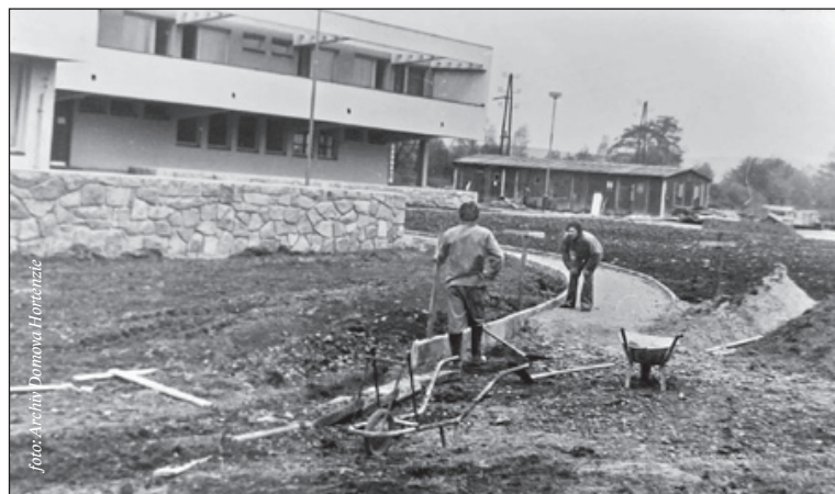
Výstavba Domova byla ukončena na jaře roku 1972, až do podzimu pak probíhalo budování chodníků a úprava okolí
