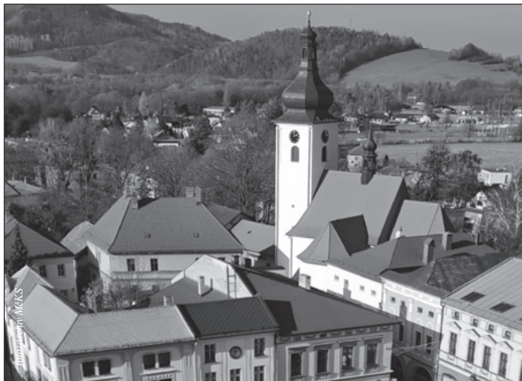
Kostel sv. Martina po obnově, listopad 2021
