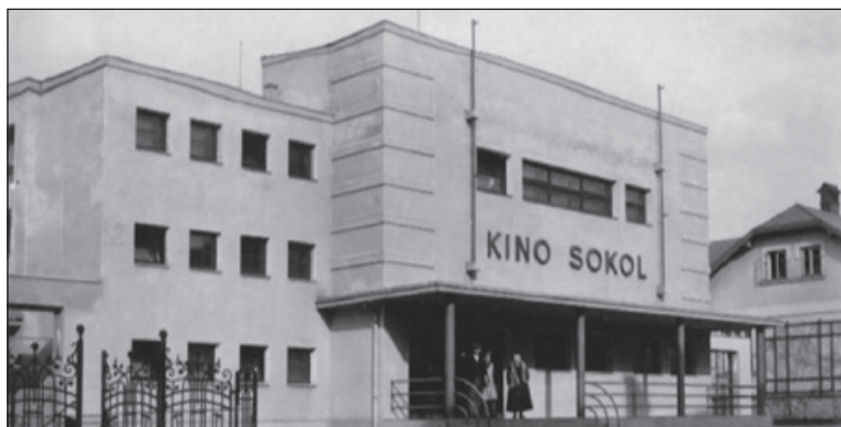
Architekt Pořízka vypracoval návrh moderního kina pro Sokol. Otevřeno bylo na Vánoce 1931. Byla zde první zvuková aparatura na Moravě
