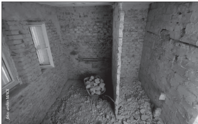
Pracovníci MěKS provedli oklepaní navlhčících omítek v zázemí amfiteátru. Část vnějšího zdiva bude nutné injektovat hydroizolační emulzí
