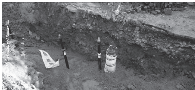
Z výstavby vodovodu Střelniční, květen–říjen 2021
