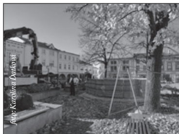
Důvodem oprav byla netěsnost nádrže, praskání kamene a narušení statiky kašny
