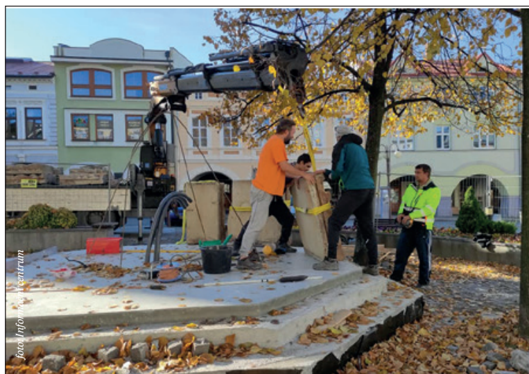
Jednotlivé kamenné bloky byly očištěny především od betonových tmelů a ocelových vložek a vráceny zpět na náměstí
