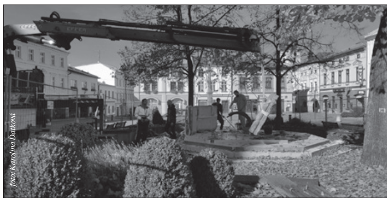
Důvodem oprav byla netěsnost nádrže, praskání kamene a narušení statiky kašny
