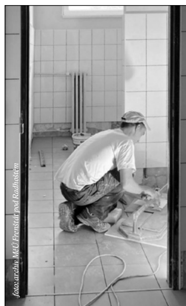
Rekonstrukci sociálního zařízení provedla firma SUBSTAV Invest, s. r. o. z Brušperku
