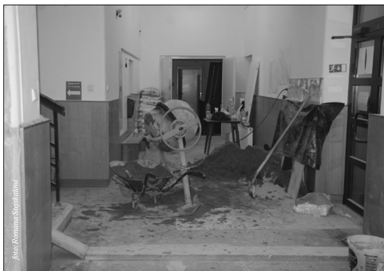
Po ukončení prací budou v budově samostatná sociální zařízení pro dívky a chlapce na každém podlaží
