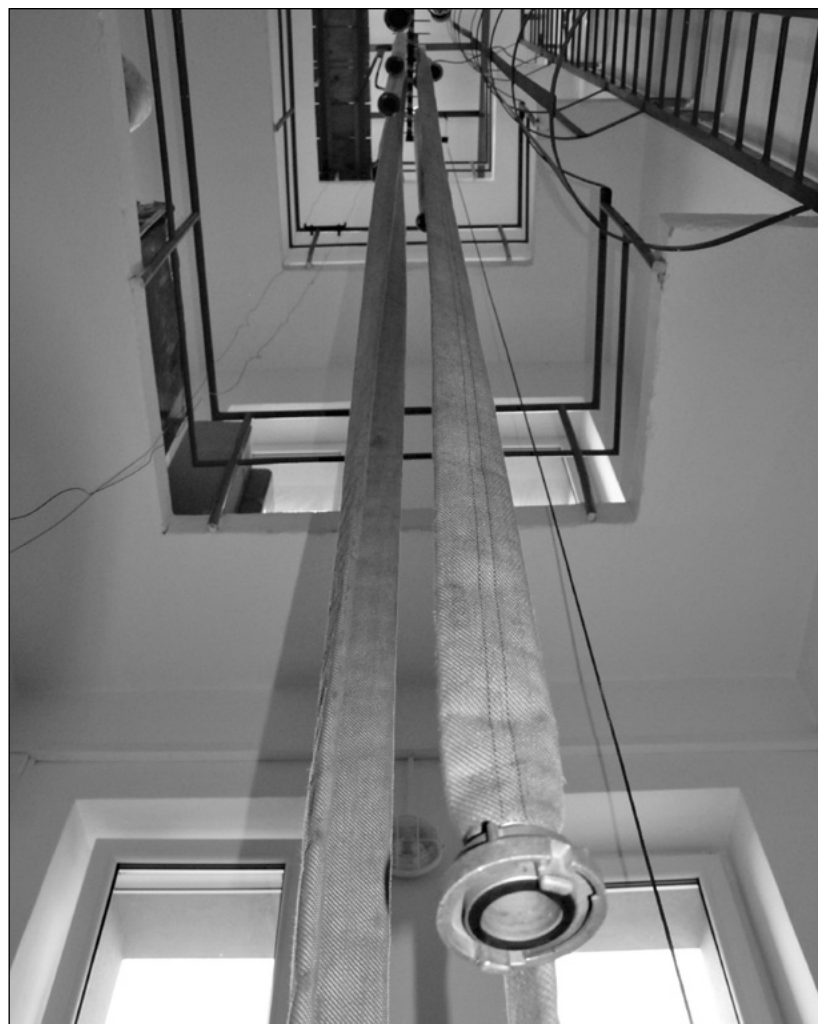
Věž na sušení hadic je vysoká čtrnáct metrů
