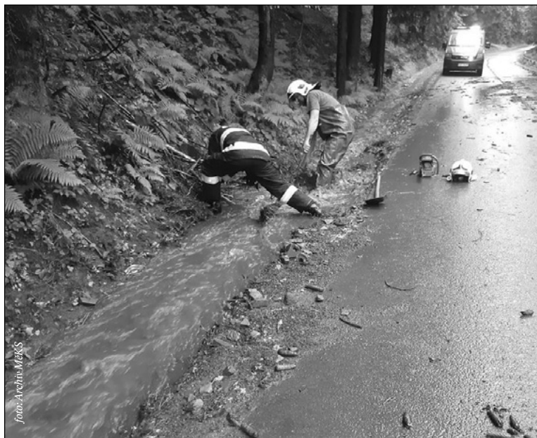
Spadlý strom, který při příválových deštích spadl do potůčku, způsobil vylití jeho koryta na cestu. Hasiči pomocí pily odstranili překážku
