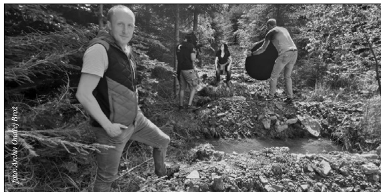
S kamarády hloubí tůně na zachycení vody
