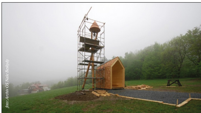
Lešení, ze kterého byl osazen pod stříšku zvonce zvon odlitý v Novém Hrozenkově
