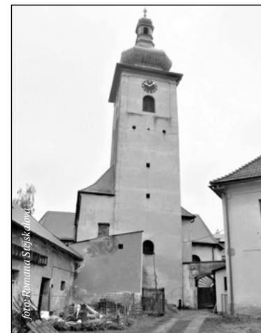
Věž kostela s bývalou prádelnou
