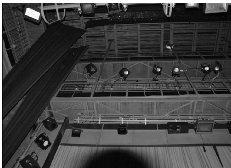
Pohled na mostovou a podmostovou baterii. Nahoře je vidět vrch provaziště (cca 18 m)
