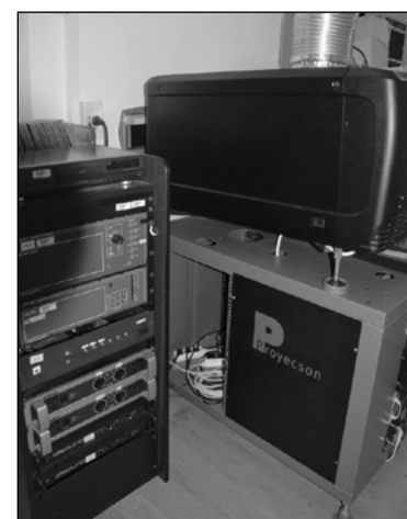
Současná promítací technika. Vpravo nahoře projektor Barco, pod ním ve stojanu rozcestník signálu Gefen, multimediální počítač a náhradní zdroj. Vlevo ve stojanu zvukový procesor Dolby, dekodér digitálního záznamu zvuku Dolby a koncové zesilovače
