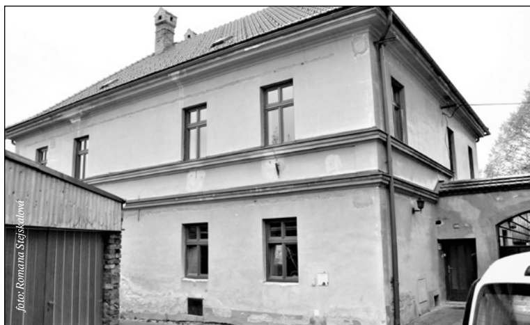
Vzhledem k vlhkosti bylo nutné odvětrat nejstarší nepodsklepenou část budovy pomocí navrtaných průduchů
