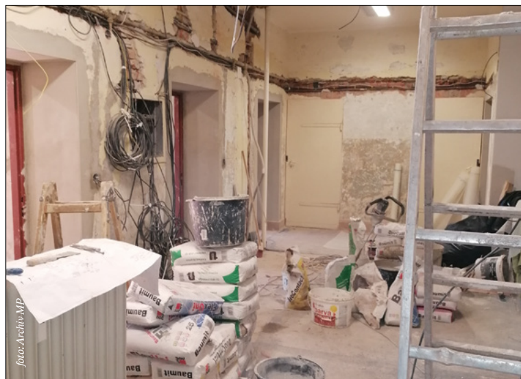
Byla provedena celková rekonstrukce vodoinstalace, elektroinstalace rozvodů a osvětlení
