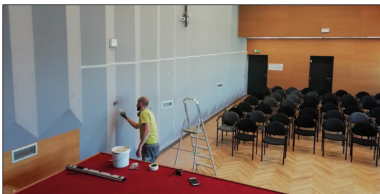
V Domě kultury se maluje, pracuje se vevnitř i venku, stěhují se sklady a opravuje mobiliář
