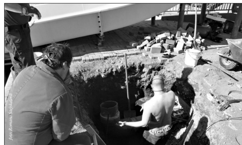
V dubnu byla nutná oprava prasklého potrubí o průměru 315 mm, které napájí atrakce akvaparku, kterou provedli zaměstnanci firmy BWT Praha
