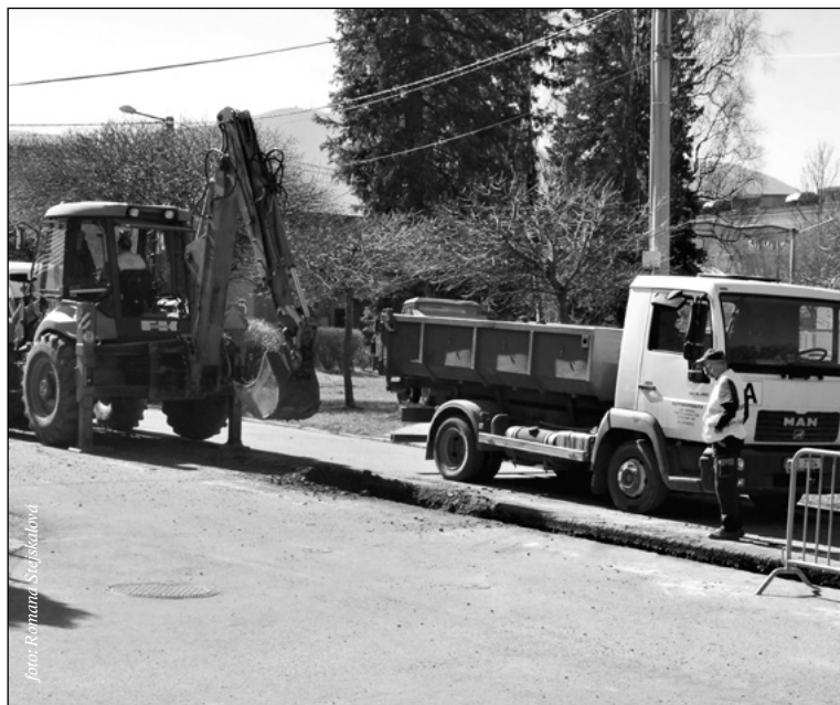
Firma PlynStav, s.r.o včas zajistí dopravní značení a informování o jednotlivých etapách rekonstrukce
