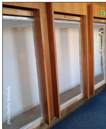
Nově vybudované vitríny v bufetu, ve kterých bude expozice staré projekční techniky
