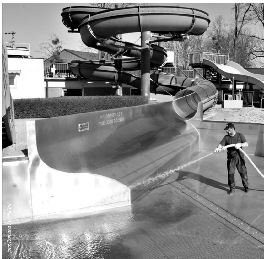
V těchto dnech probíhá na akvaparku čištění bazénů a tobogánů, čištění nosných konstrukcí a akumulačních nádrží
