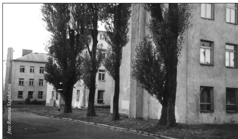
Domy v Martinské čtvrti bylo nutné opravit
