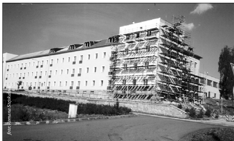
Dva domy bývalých prvorepublikových kasáren prošly rozsáhlou rekonstrukcí
