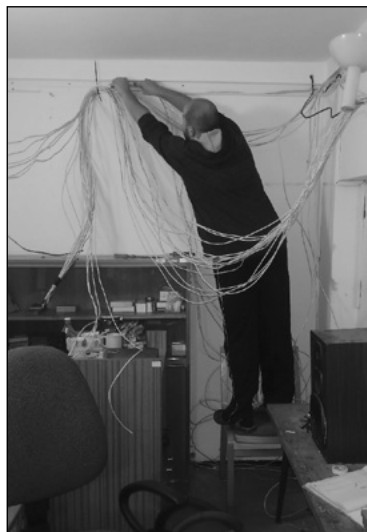
Kdybychom všechny síťové kabely umístili za sebe, dosahovaly by délky skoro 1 km. Celkem se u centrálního rozvaděče sbíhá 45 různých linek.
