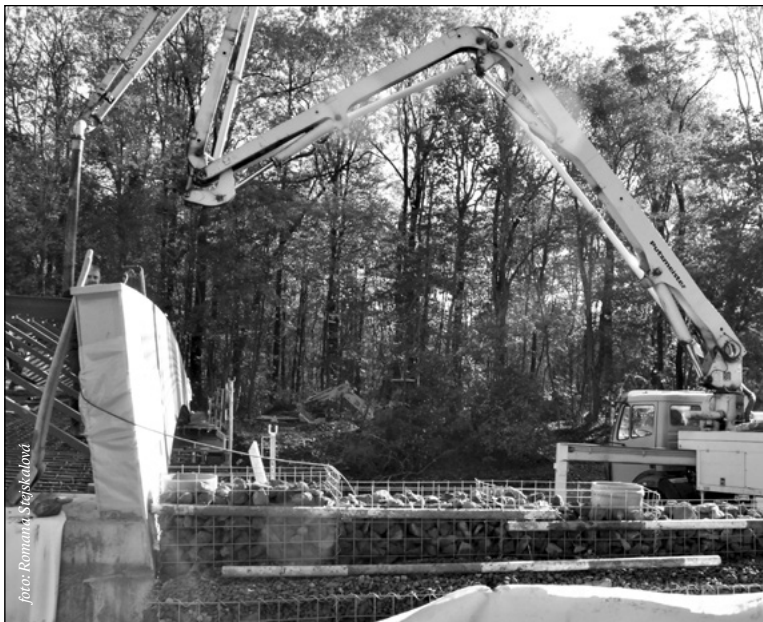
V říjnu byla osazena ocelová konstrukce lávky, provedena zátěžová zkouška a betonáž mostovky
