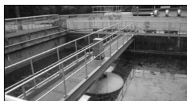
Dosazovací nádrž v biologické části čis- tírny. Odděluje se kal, který směřuje dále do čistírenského procesu, a vyčištěná voda odtékající do Lubiny
