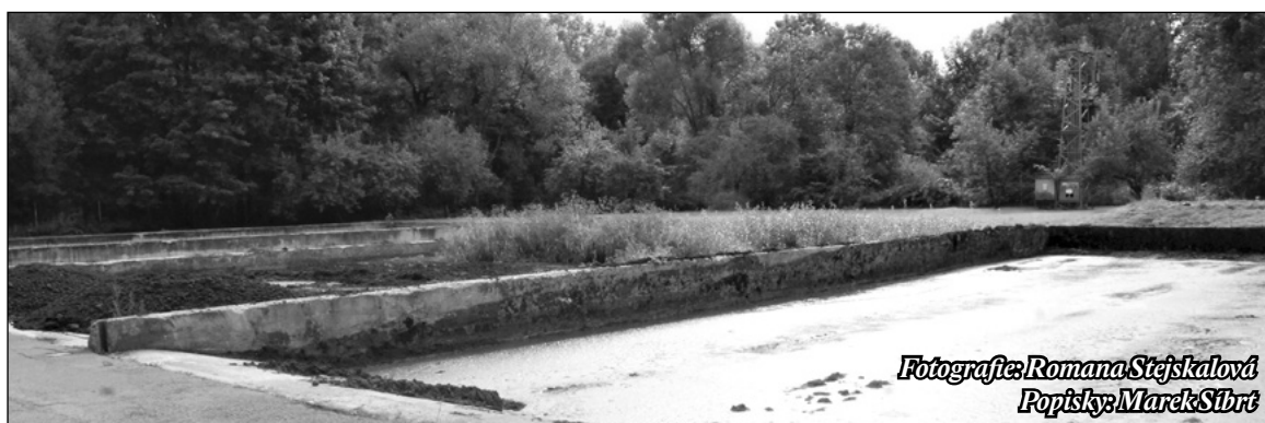
Kalová pole. Díky stále efektivnějšímu čistírenskému procesu již není potřeba uskladňovat tak velké množství kalu. Ten je zahušťován v odstředivce a je ho produkováno menší množství, než tomu bylo v minulosti
