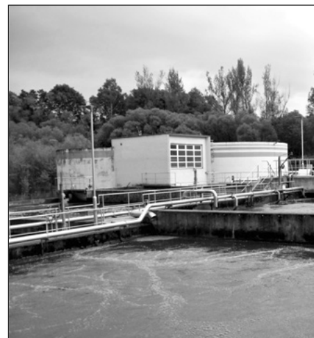
V přední části snímku je aktivační nádrž, která je znečištěna působením mikroorganismů. Za ní regenerační nádrž
