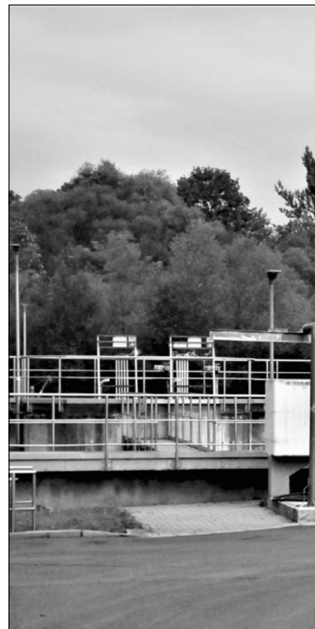
Nalevo je vstupní čerpací stanice přivádějící odpad
