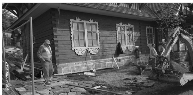
Dokončeno bylo dláždění dvora Libušína a okolních zpevněných ploch
