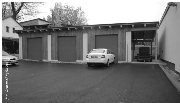
Nový sklad, oprava manipulační plochy a nové oplocení byly dokončeny v areálu Hasičské zbrojnice
