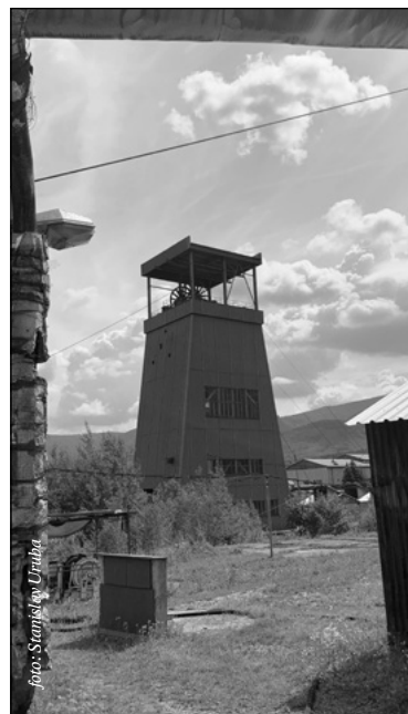
V areálu, kde se nikdy netěžilo, je zhruba padesát staveb. V minulosti jim vypršelo stavební povolení
