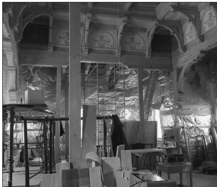
Hrubá stavba je hotová, finišují práce v interiérech
